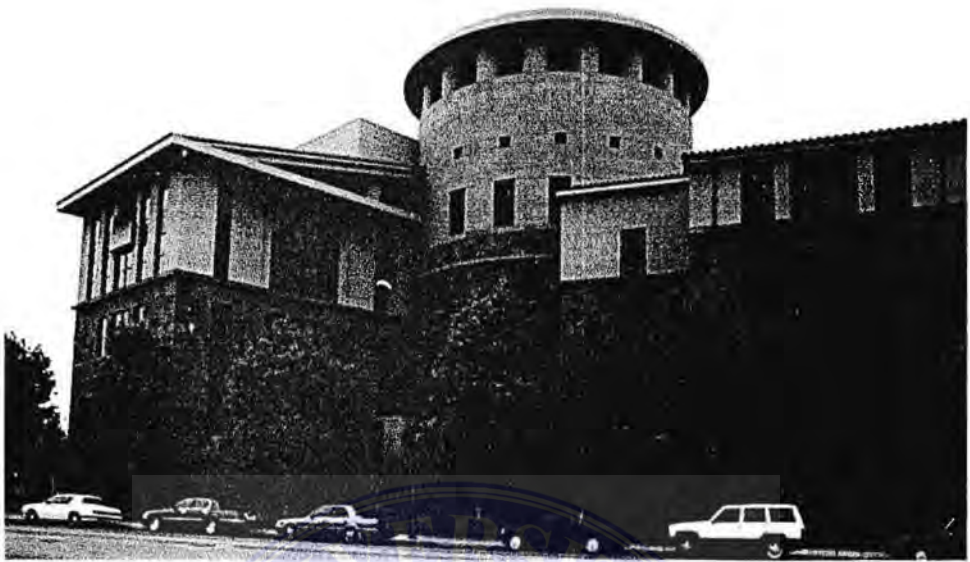
Foto II.12. Sisi lain pada bangunan, terlihat bentuk silinder pada sudut bangunan
