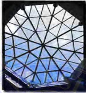
Gambar 81. Material fiber pada atap dome
