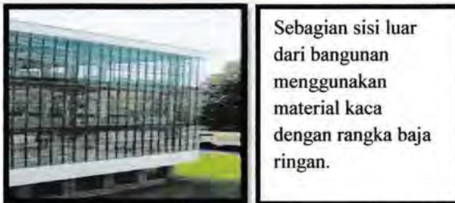
Gambar : 5.18. Dinding menggunakan Kaca
