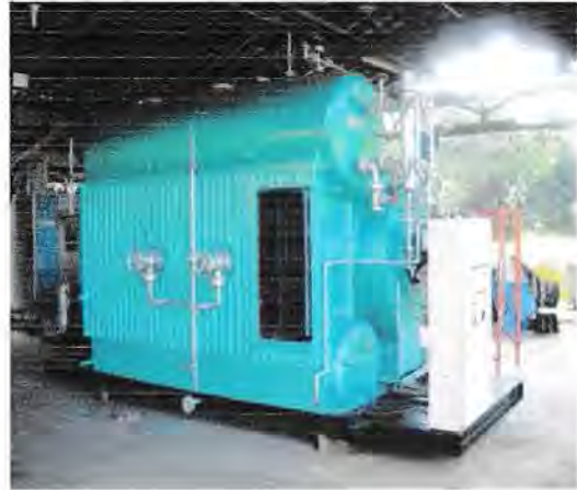
Gambar 2.3.1. Ketel pipa Api
