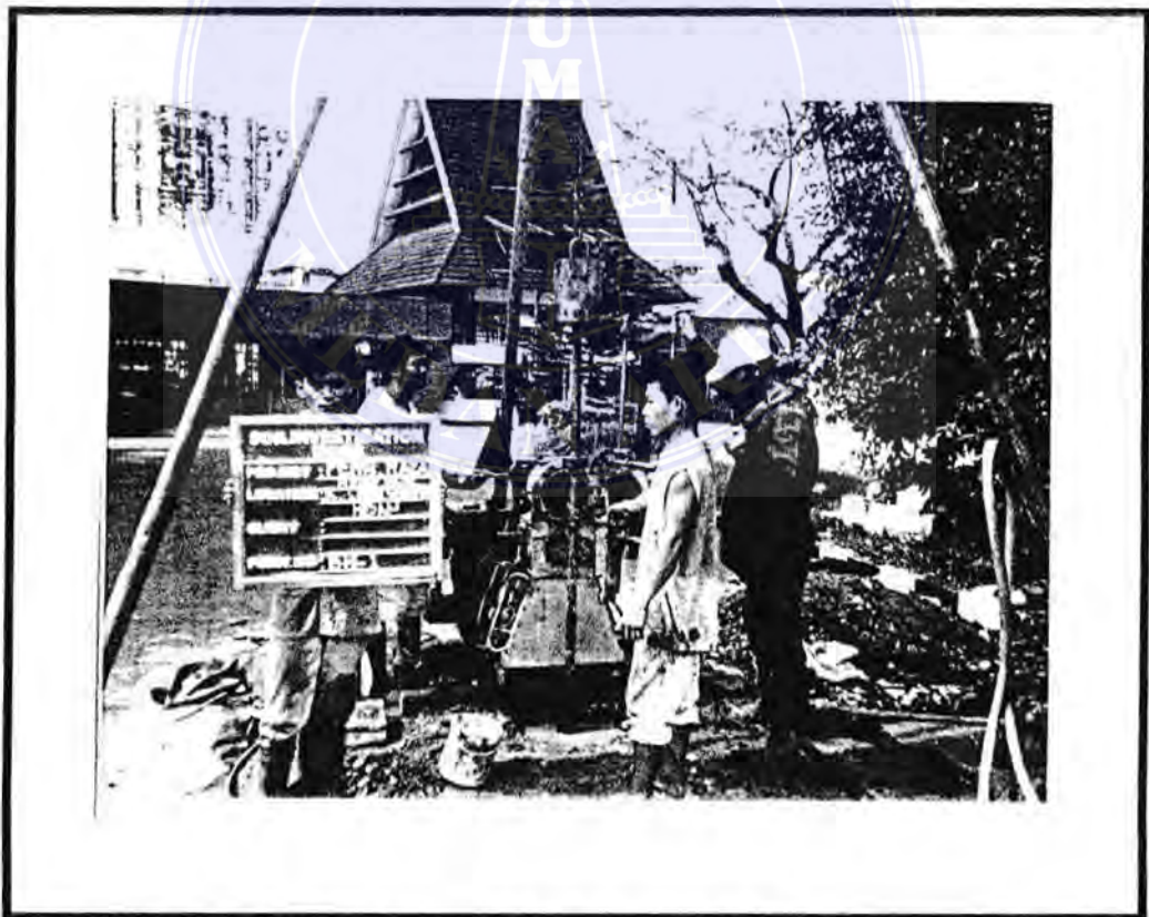
Gambar 2.5.2.2.1. Pelaksanaan Pengeboran Dengan Mesin Dan Pengujian Standard Penetration Test
