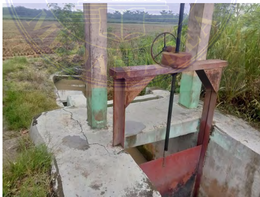
Gambar 2. Bangunan Pintu Pengambilan ( Intake )
