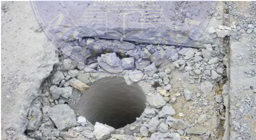
Gambar 5. Hasil pembobokan sisa ketinggian tiang pancang sampai level rencana yang telah ditentukan dengan menggunakan jack hammer
