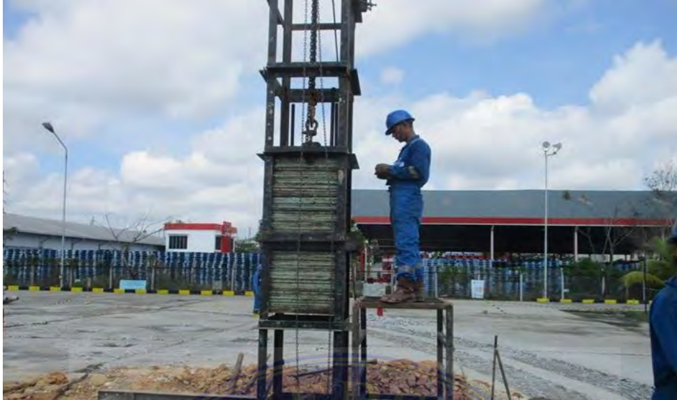
Gambar 9. Pemeriksaan persiapan PDA tes ( pile drive analysis ) setelah semua unit telah terpasang
