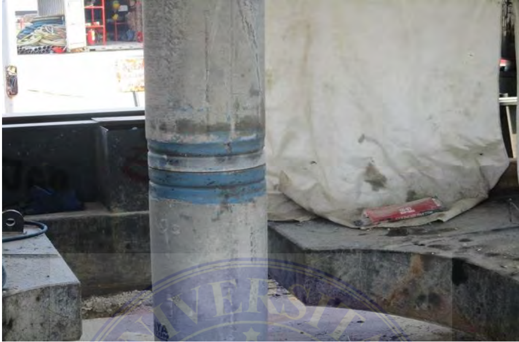
Gambar 4. Persiapan penyambungan tiang pancang antara upper dengan pencil yang akan dilakukan dengan menggunakan welding set
