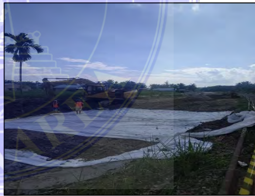
Lampiran 3: Pemasangan lapisan geotextile
