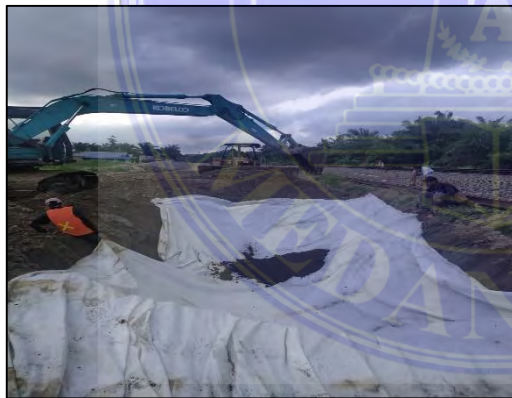
Lampiran 3: Pemasangan lapisan geotextile
