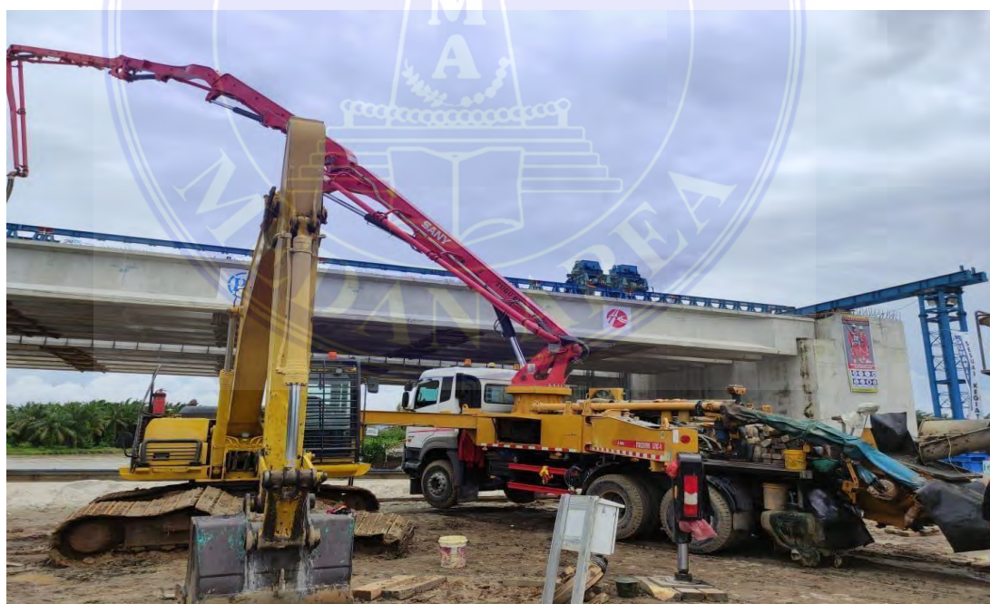
Gambar. Pengecoran Diagrama Jembatan (PT. PP, 2021)
