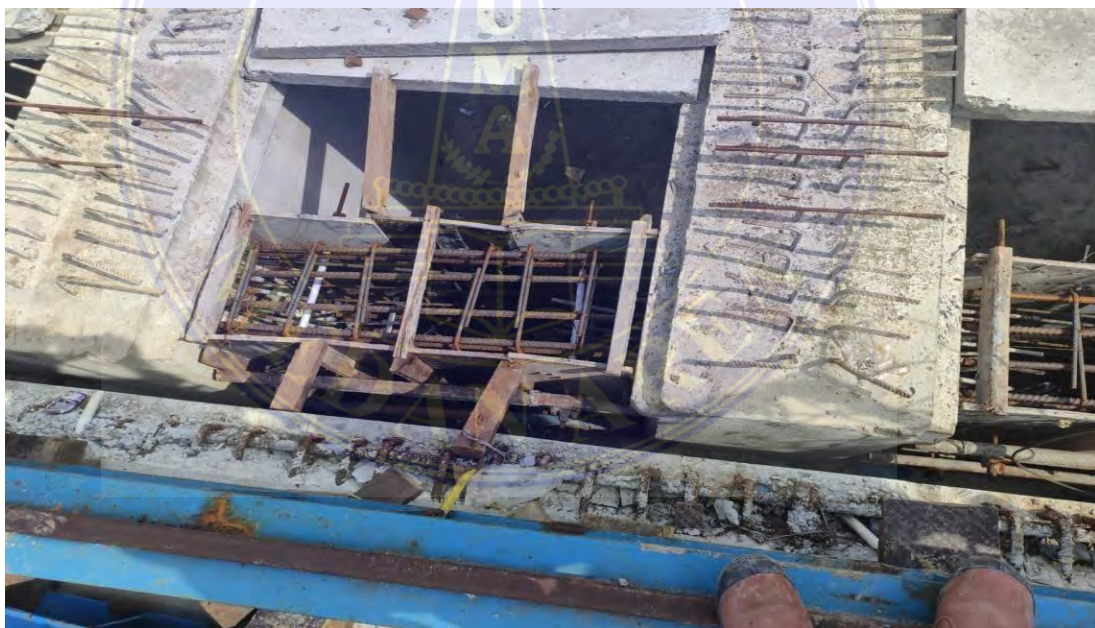
Gambar. Tampak Diagrama Sebelum Dicor (PT. PP, 2021)
