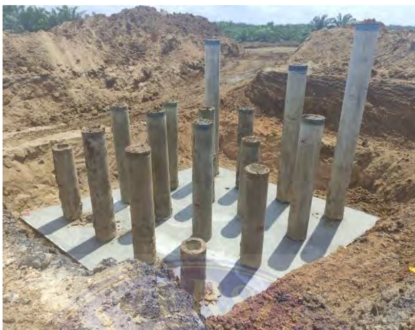
Gambar 8. Pondasi tiang pancang jembatan ( PT. PP, 2021 )
