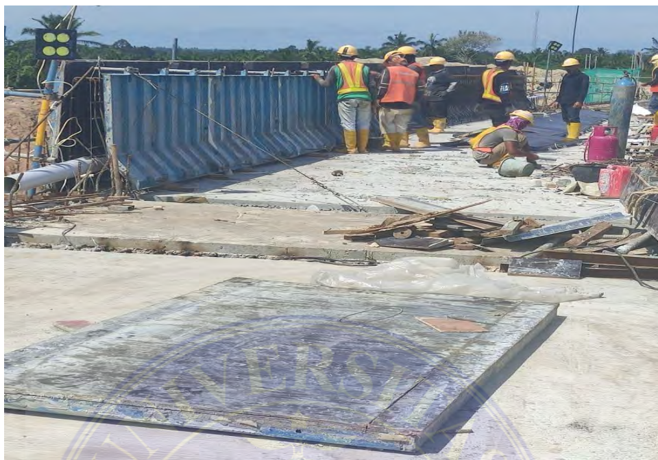
Gambar. Pemasangan Bekisting Barrier Jembatan (PT. PP, 2021)
