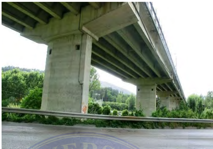
Gambar 17. Jembatan beton bertulang balok T ( Kontruksi Media, 2022)
