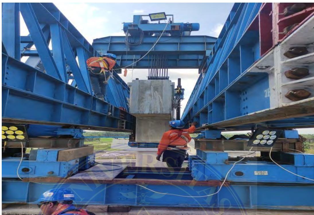
Gambar. Pengangkatan balok Girder Menggunakan Luncher Gantry (PT.PP, 2021)
