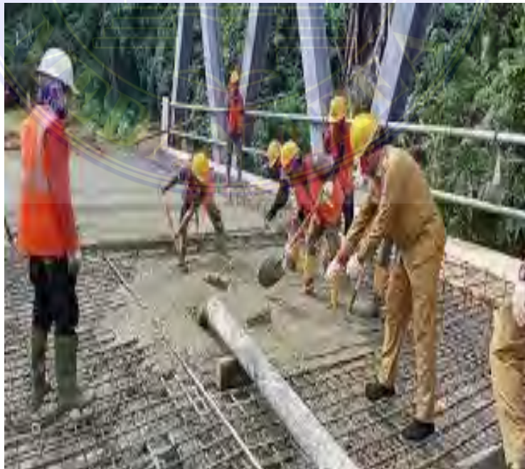
Gambar 28. Pelat Lantai Jembatan ( Tubar News, 2020 )
