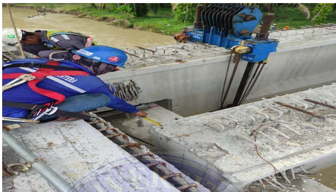
Gambar. Pengukuran Jarak Antar Girder (PT. PP, 2021)
