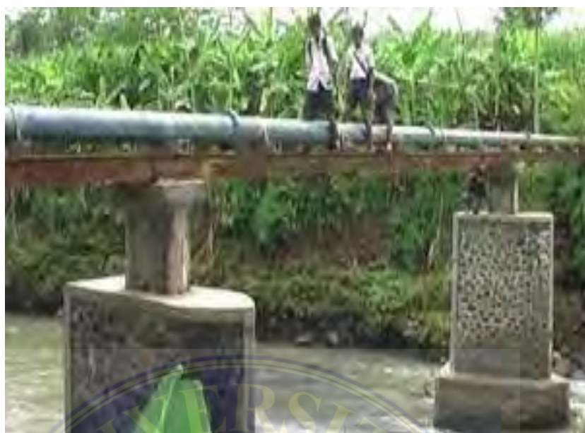
Gambar 22. Jembatan PDAM ( Okezone News, 2012 )
