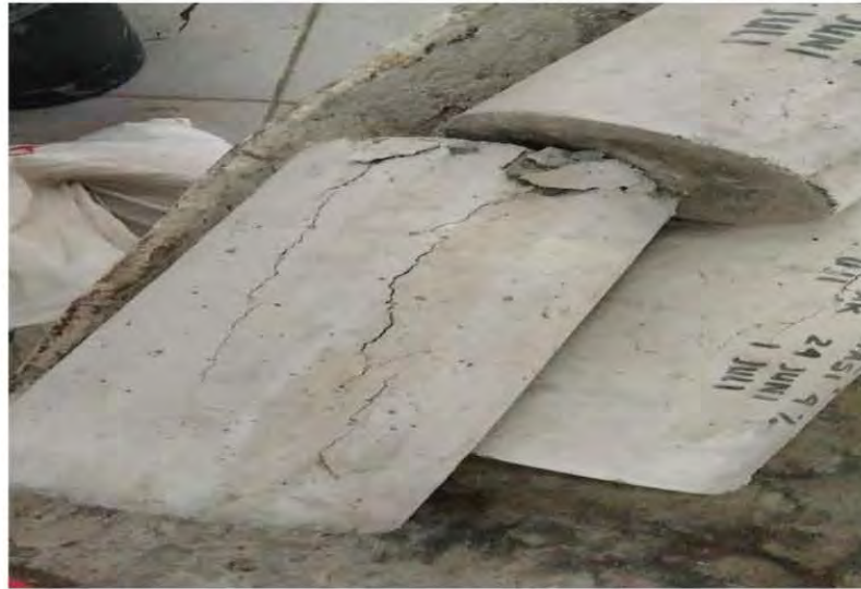
Kondisi benda uji setelah dilakukan uji kuat tekan beton (Penelitian, 2023)
