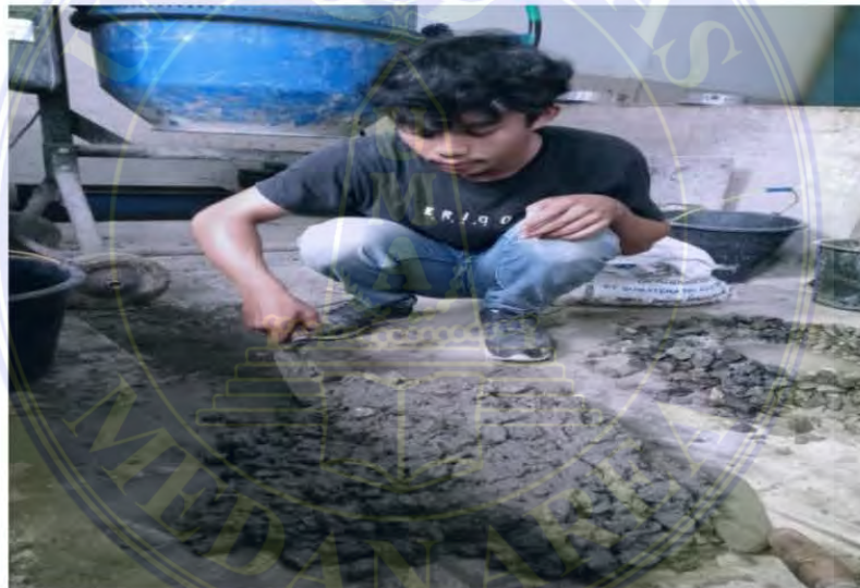
Pengadukan beton (Penelitian, 2023)
