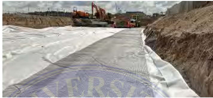
Gambar 5: Penghamparan Geotekstil (Fransiskus, 2019)
