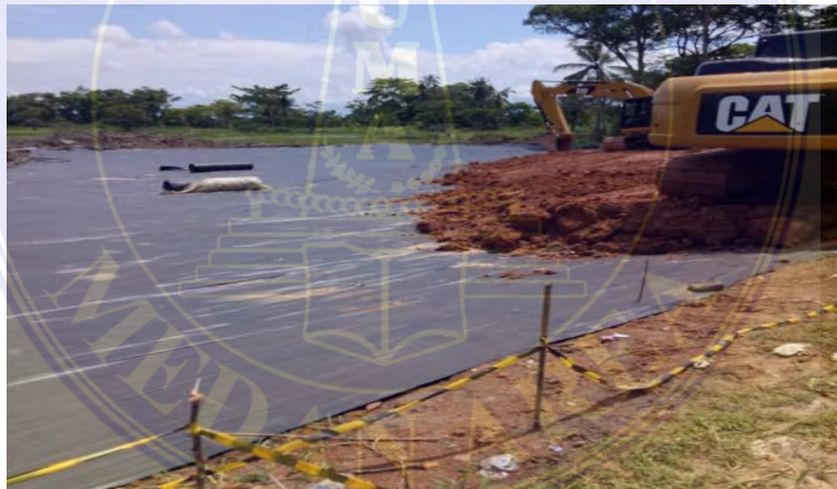
Gambar 9. Proses pemadatan pada tanah berbutir (KTG Marcomm, 2021)
