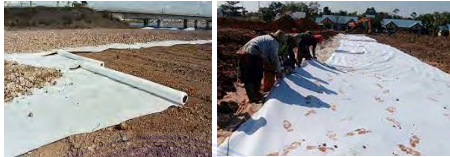
Gambar 8. Proses penghamparan geotextile (Fransiskus, 2019)
