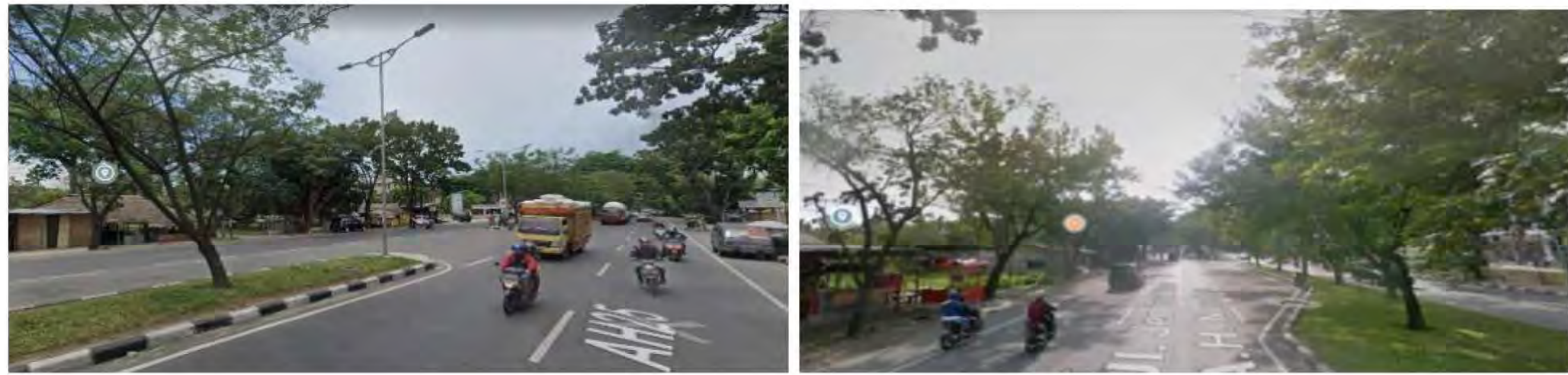
Gambar 3. 4 Kondisi Eksisting Geometrik Ruas jalan AH Nasution
