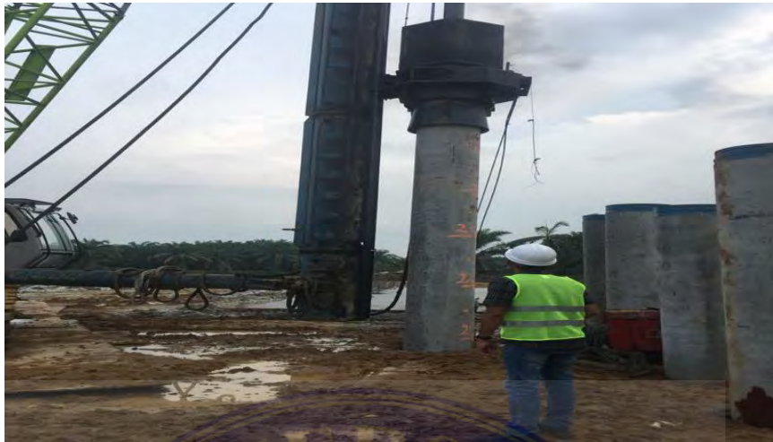
Gambar 3. Proses Pemukulan Tiang Panjang ( Spun pile )
