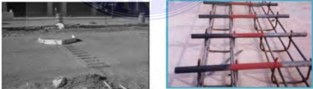
Gambar 9. Sambungan Susut Melintang (Diklat perkerasan kaku, 2017)
