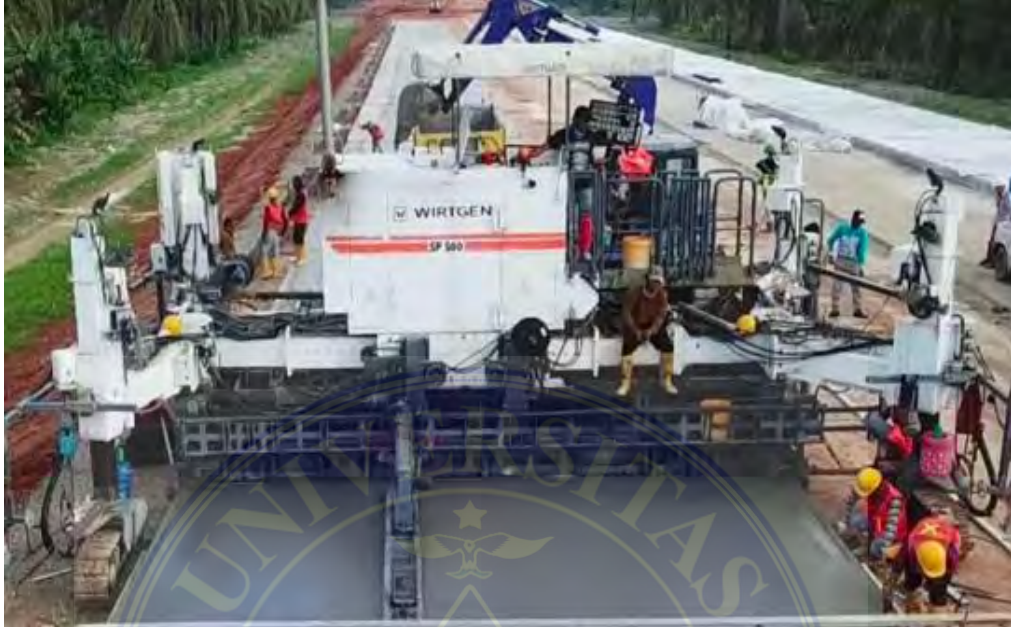
Gambar 10. Slipform Wirtgen SP500 ( dokumentasi proyek, 2023)
