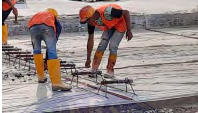
Gambar 2. Pemasangan dowel menggunakan chair (dokumen proyek, 2023)
