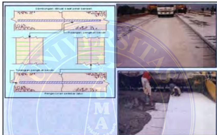
Gambar 5. Sambungan Memanjang (Diklat perkerasan kaku, 2017)
