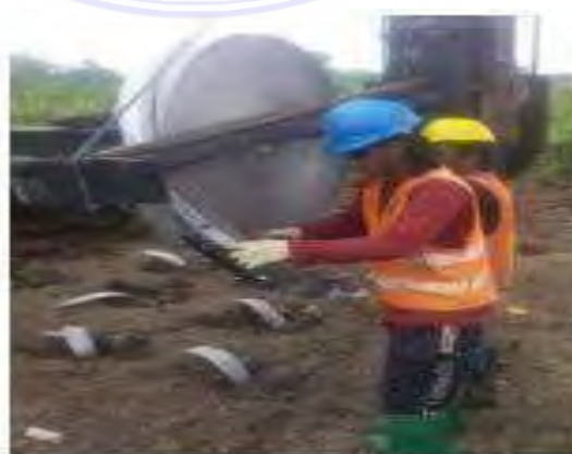
Gambar 9 Pemasangan Roll PVD (Konsultan Perencana,2022)
