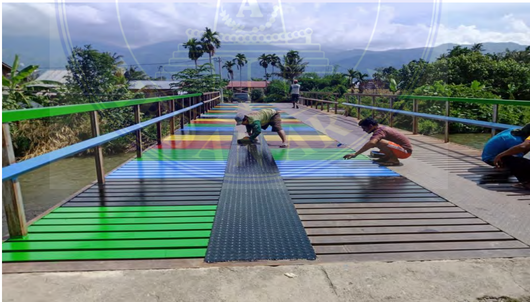
(Kondisi Jembatan Terkini, 2023)
