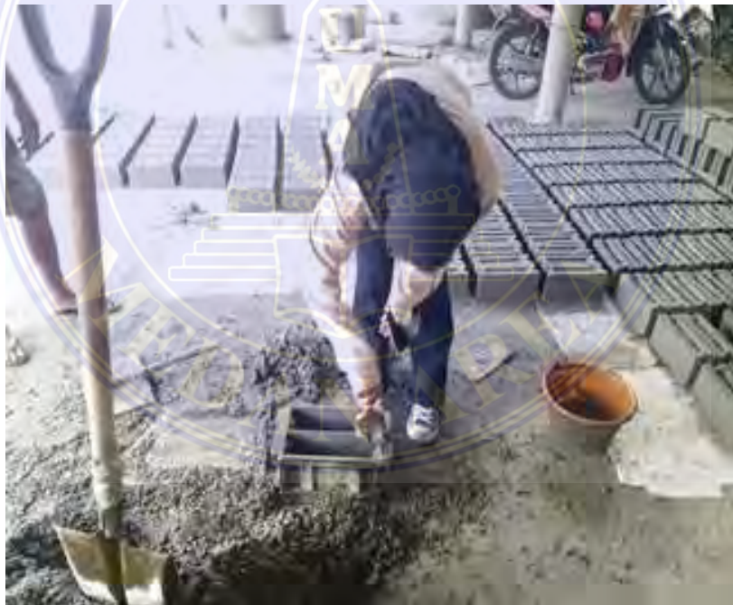
Pengolesan Oli Pada Cetakan Agar Sampel Mudah Dikeluarkan
