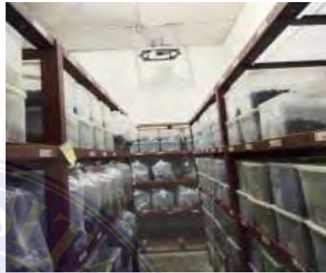
Gambar 6. Situasi ruang pemanas Sumber : Pribadi, penelitian 2023
