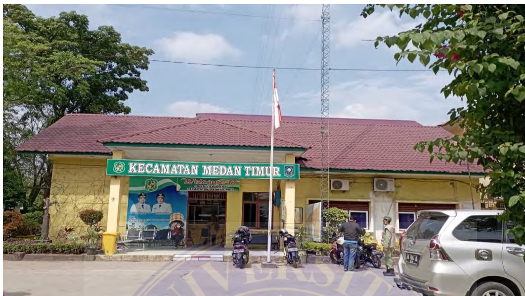
Gambar 1. Kantor Camat Medan Timur (Sumber: Dokumen Pribadi, Selasa 15 Februari 2022)
