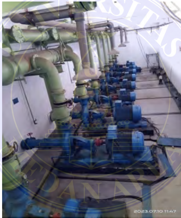
Gambar 3.1. Pompa Sentrifugal
