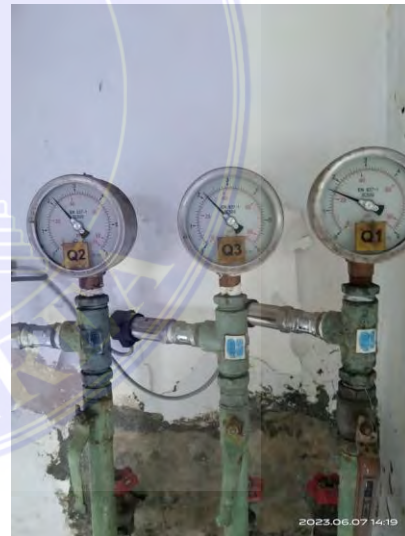
Pengukuran Tekanan Air
