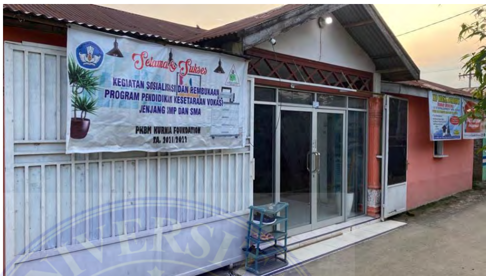
Gedung sekolah PKBM Kurnia Foundation yang terletak di Jl. Limau Manis Pasar 13 Dusun V Gang Sedulur
