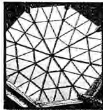
Gambar 109. Material fiber pada atap dome
