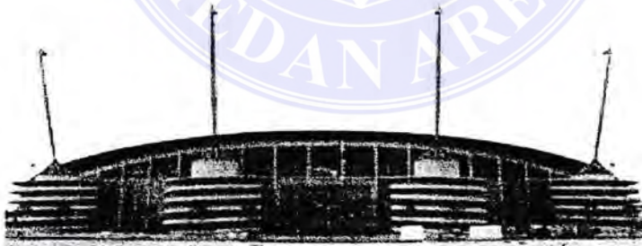
Tampak sisi kanan bangunan
