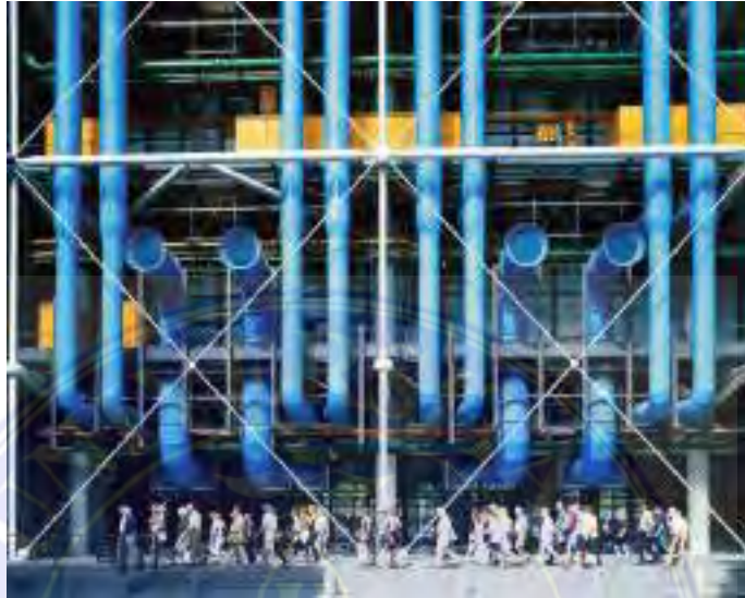
Gambar: 2.5 fasad bangunan Center pampidou
