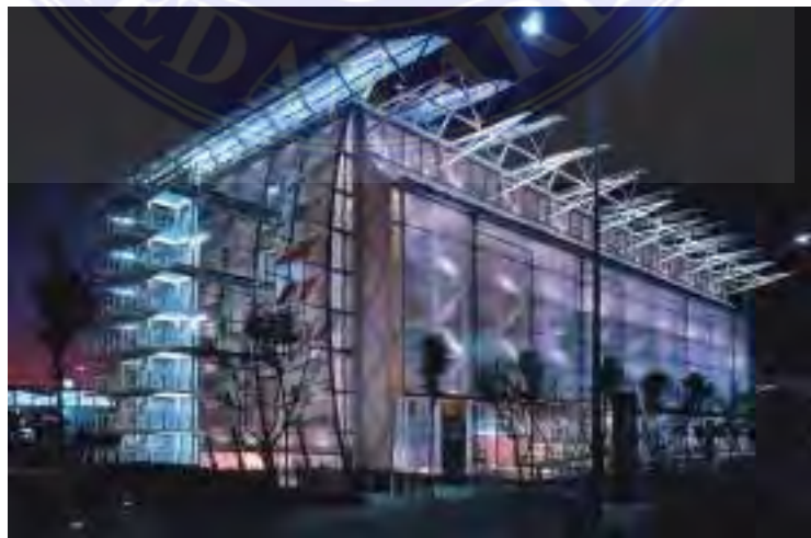
Gambar: 2.7 Bangunan British Pavilion
