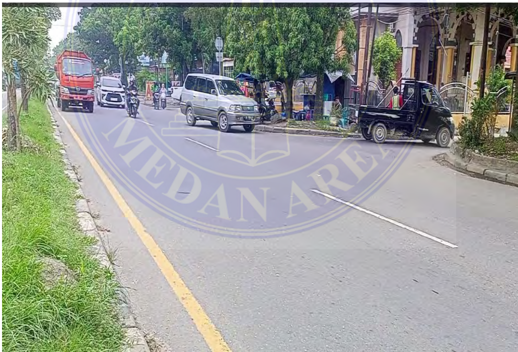
Kondisi Jalan Asrama saat berlangsungnya proyek underpass Gatot Subroto
