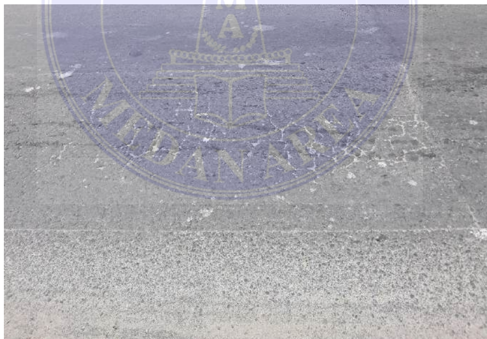
Gambar: Jenis Kerusakan Retak Blok
