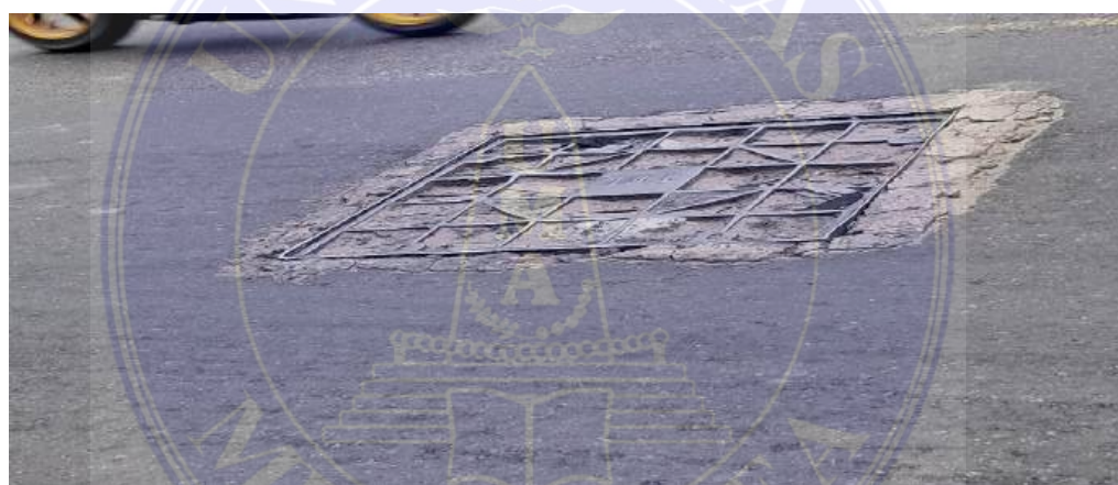
Gambar: Pengukuran Dimensi Kerusakan Tambalan
