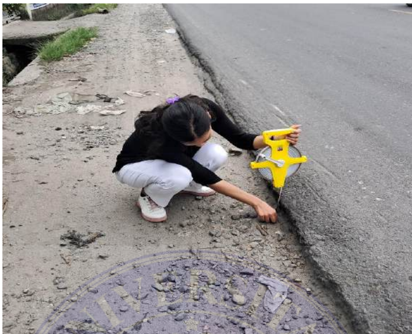
Gambar: Pengukuran Dimensi Kerusakan Pinggiran Jalan Turun
