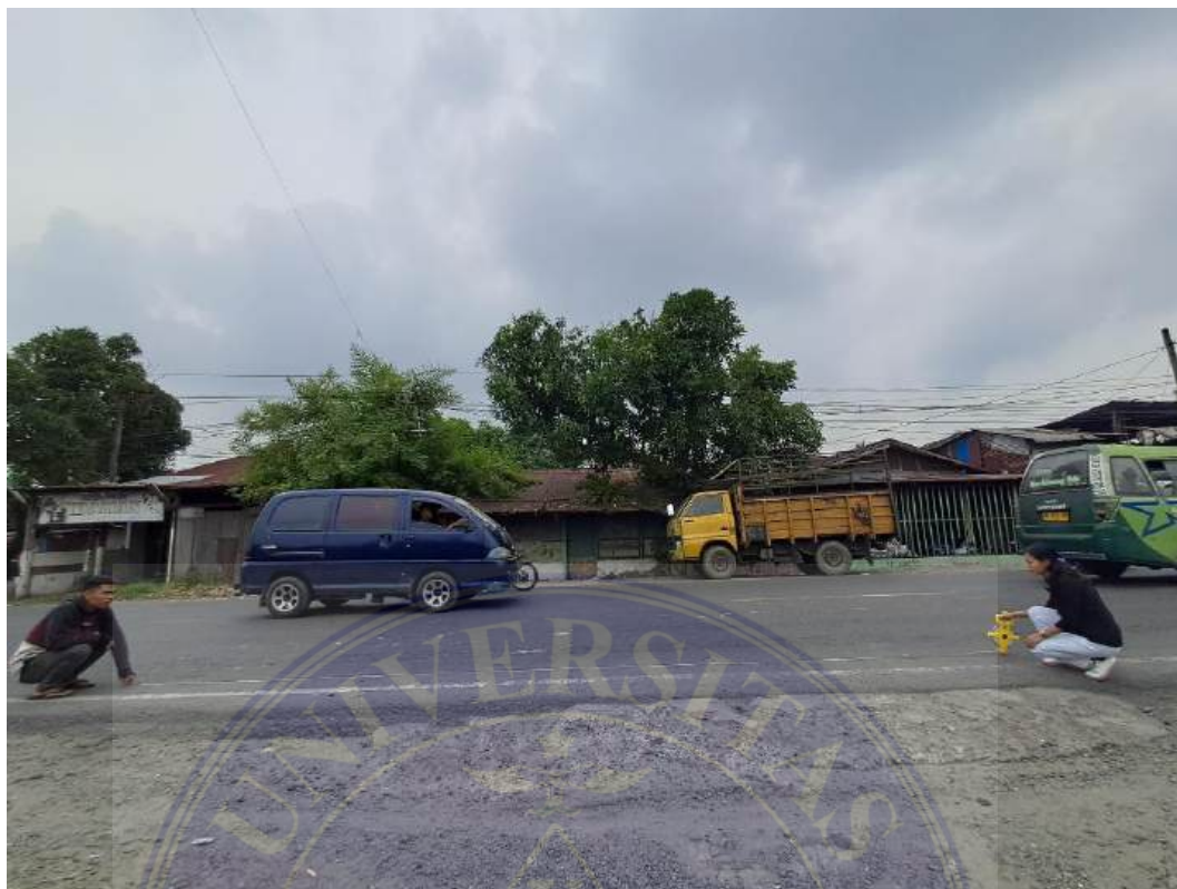
Gambar: Pengukuran Dimensi Kerusakan Retak Buaya
