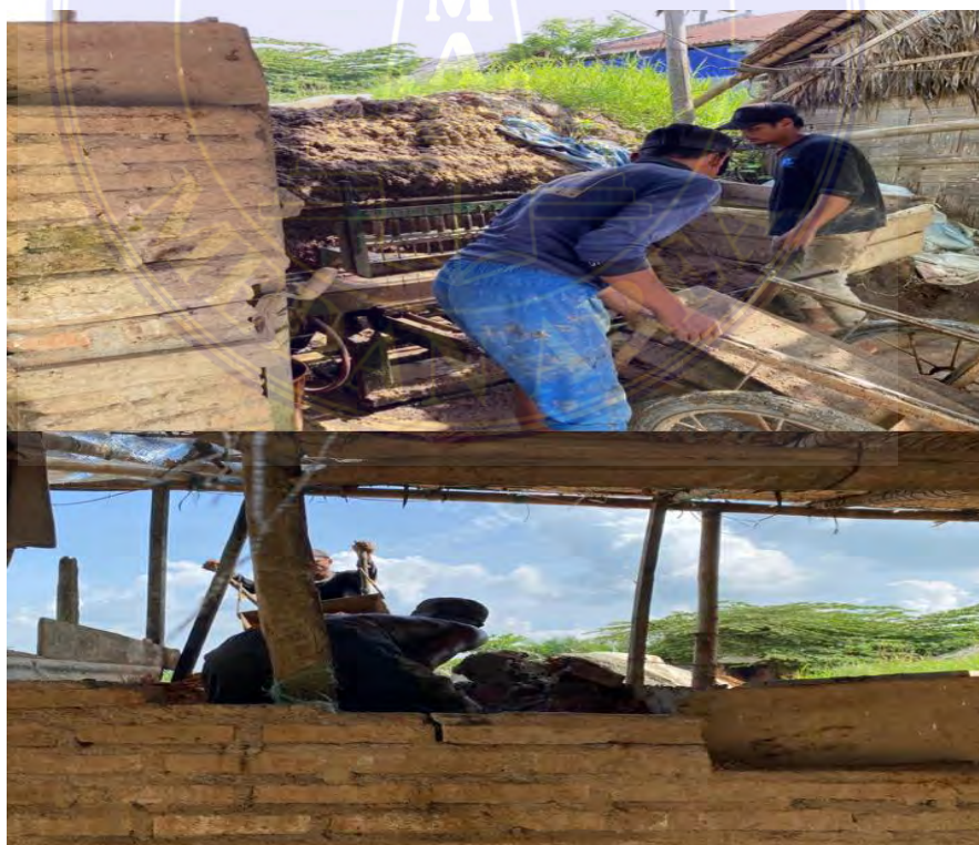
Dokumentasi Proses Pembuatan Batu Bata (Sumber: Dokumen Pribadi, 2024)
