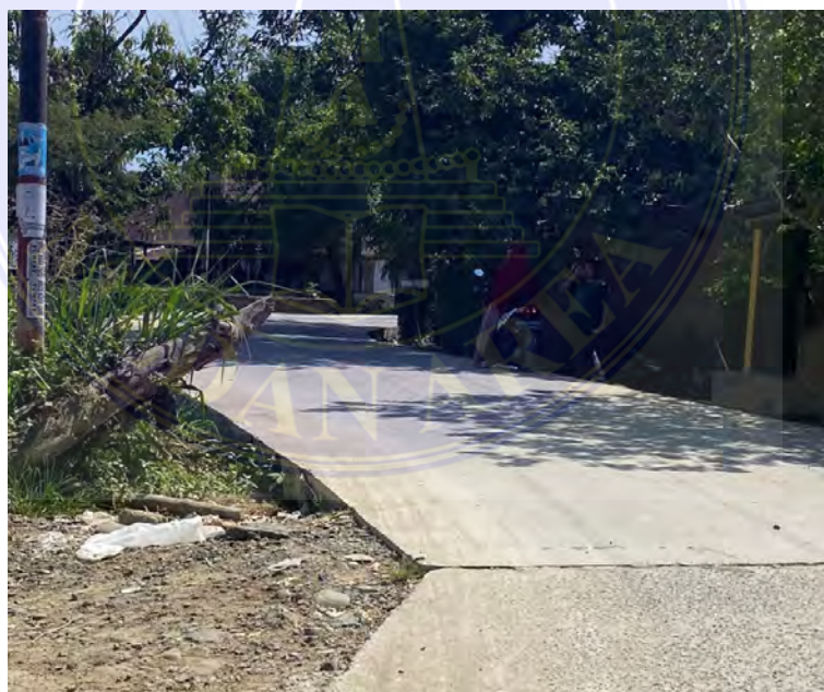
Bentuk Kontribusi Dari Pemerintah Memberikan Jalan Khusus Untuk Transportasi Produksi Batu Bata. (Sumber: Dokumen Pribadi, 2024)
