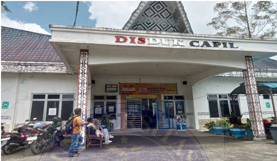
Foto Dinas Kependudukan dan Pencatatan Sipil Kabupaten Simalungun Di Jalan Kartini Pematang Raya, Sondi Kecamatan.
