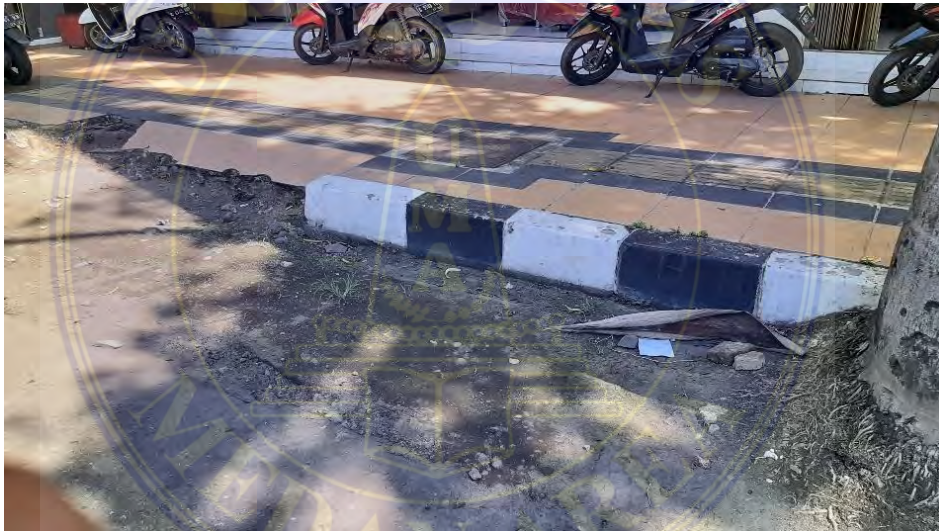
Gambar 4. Jalan dan kereb
