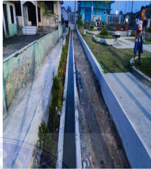
Kondisi Saluran Drainase Sekunder
