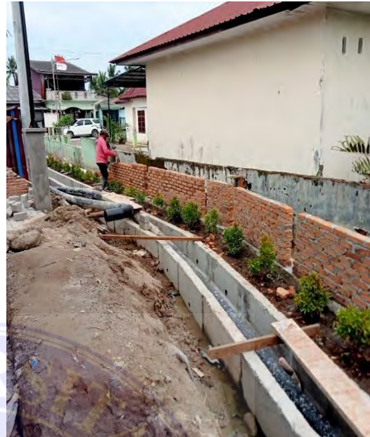
Kondisi Saat Pengerjaan Saluran Drainase Sekunder
