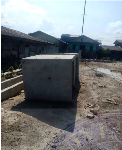
Kondisi Saat Pengerjaan Saluran Drainase Primer
