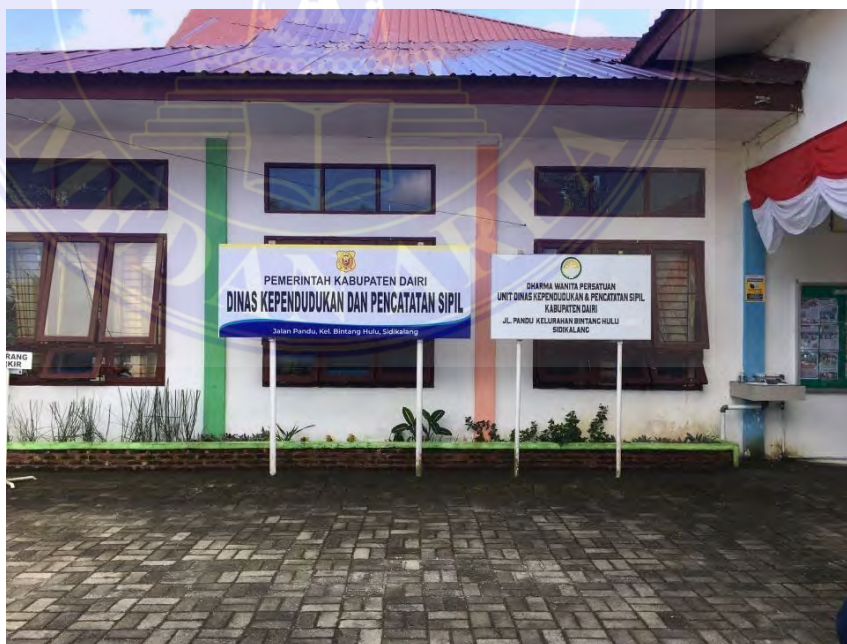
Gambar 2. Bagian Samping Dinas Kependudukan dan Catatan Sipil Kabupaten Dairi
