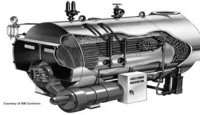
Gambar 2.5. Jenis Boiler 3 pass, bahan bakar minyak
