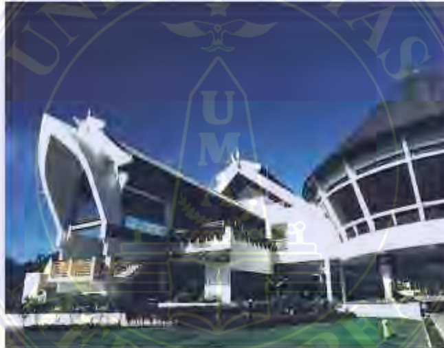
Gambar 2.20 eksterior Dewan Suarah Bau Sarwak
