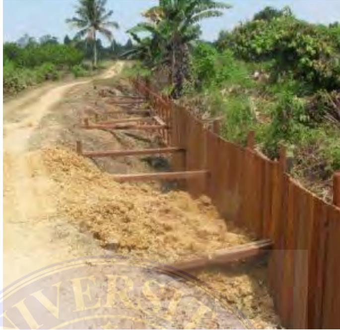
Gambar 9. *Sheetpile* Kayu (Mutuutamageoteknik, 2023)
