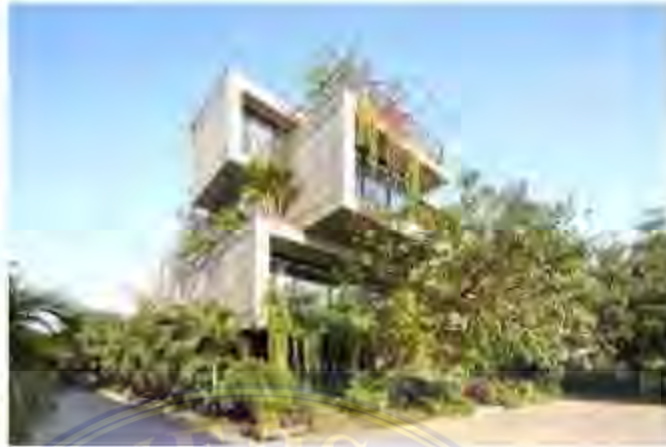
Gambar 2 15 Eksterior bangunan Meditation Office, Vietnam
