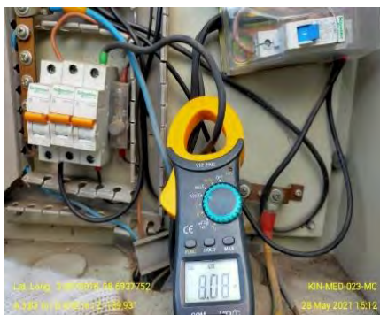
Gambar 3.13: Load (Beban) Phase R (KWH - ACPDB)
