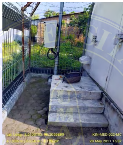
Gambar 3.3: Melakukan pembersihan bangunan shelter
