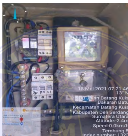
Gambar 3.18 Setelah modul selesai di restart , selanjutnya melakukan pengecekan kabel instalasi pada KWH.
