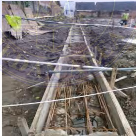
Gambar 3.15 Pekerjaan Bekisting
