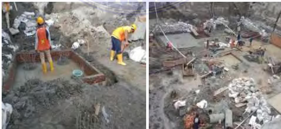
Gambar 4.12 Pekerjaan Urungan Pasir, Bekisting serta Lantai kerja
