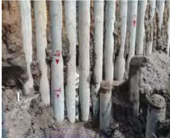
Gambar 4.1 Struktur dinding Penahan tanah
