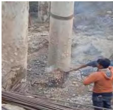
Gambar 4.11 Pemotongan tiang Pancang
