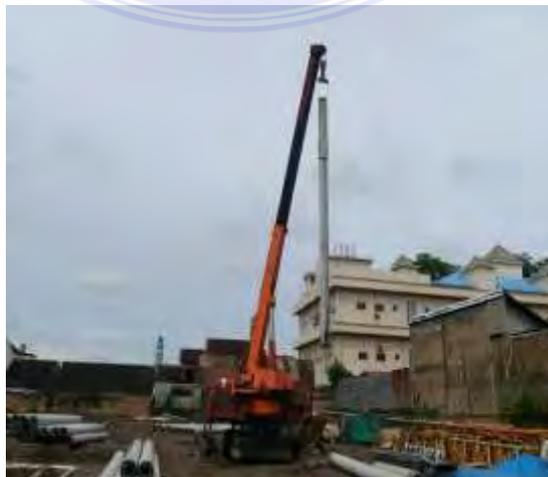
Gambar 3.11 Pemasangan *Spun Pile*
