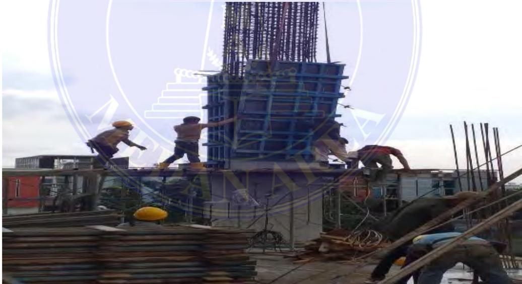
*Gambar 3.22 Pembongkaran Bekisting Kolom*
