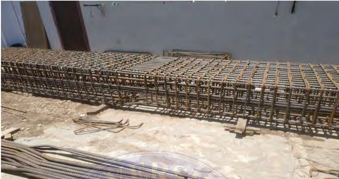
Gambar 3.19 Pemasangan Tulangan Kolom
