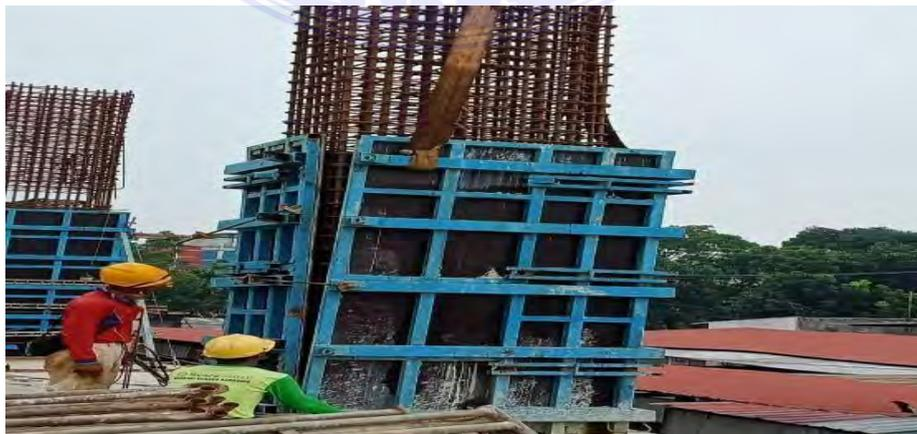
Gambar 3.20 Pemasangan Bekisting Kolom
