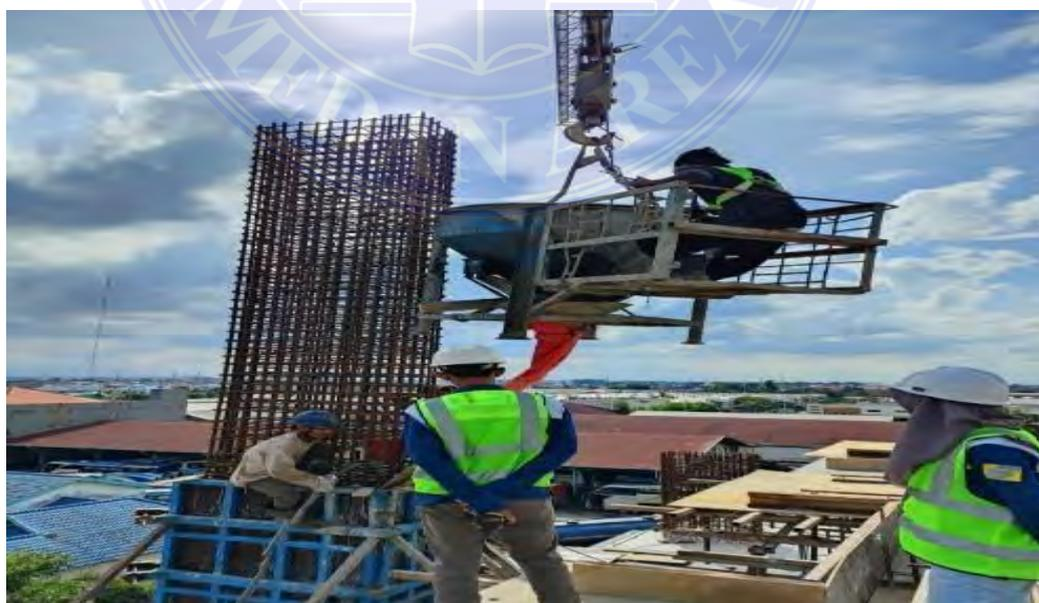
Gambar 4 Pengecoran Kolom
