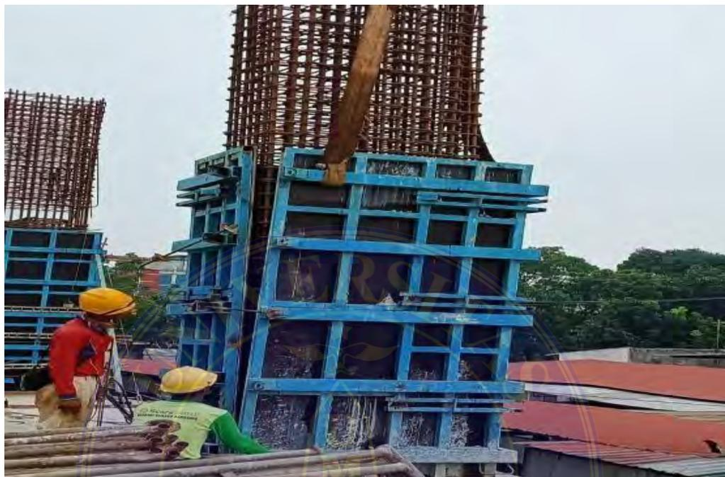
Gambar 3 Pemasangan Begesting Kolom
