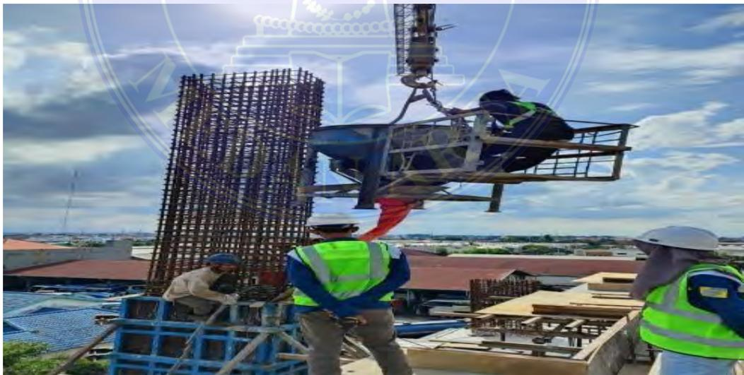
Gambar 3.21 Pengecoran Kolom
