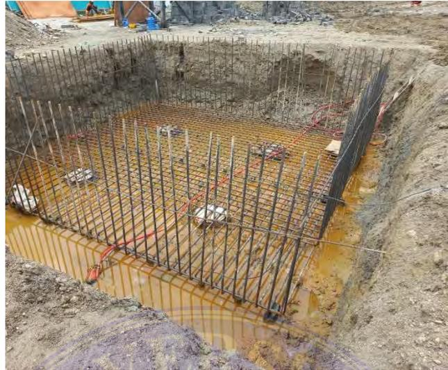
Gambar 5. 4. Pemasangan Penulangan
