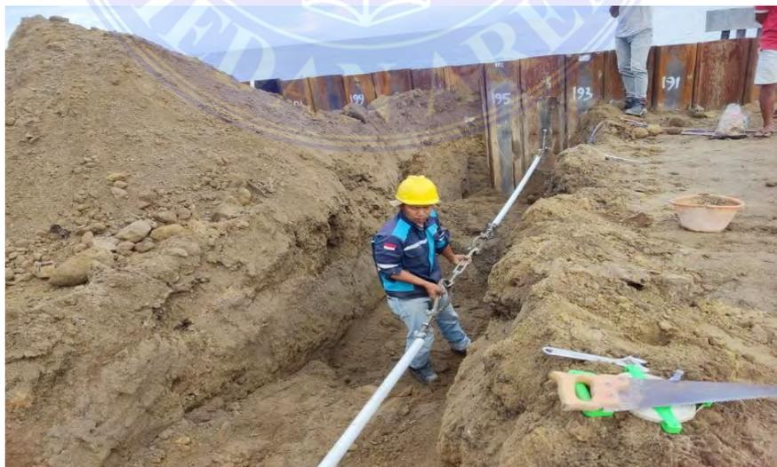
Gambar 4.8 Pemasangan sling baja
