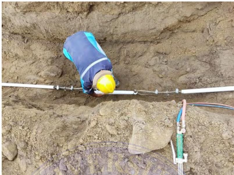
Gambar 4.9 Pemasangan sling baja sebelum ditimbun
