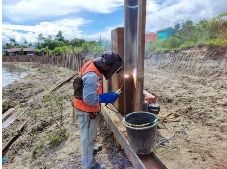
Gambar 4.7 Pemotongan *sheetpile*
