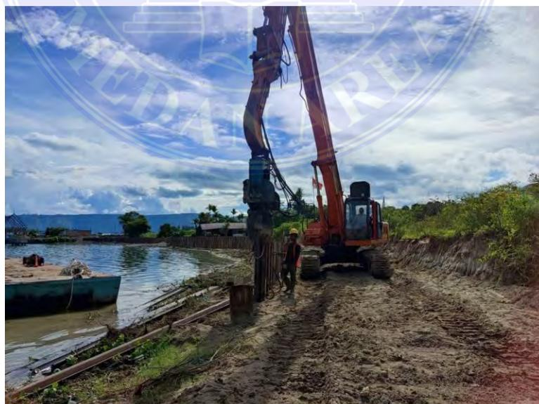
Gambar 3.3 *Vibratory Hammer* pada saat bekerja
