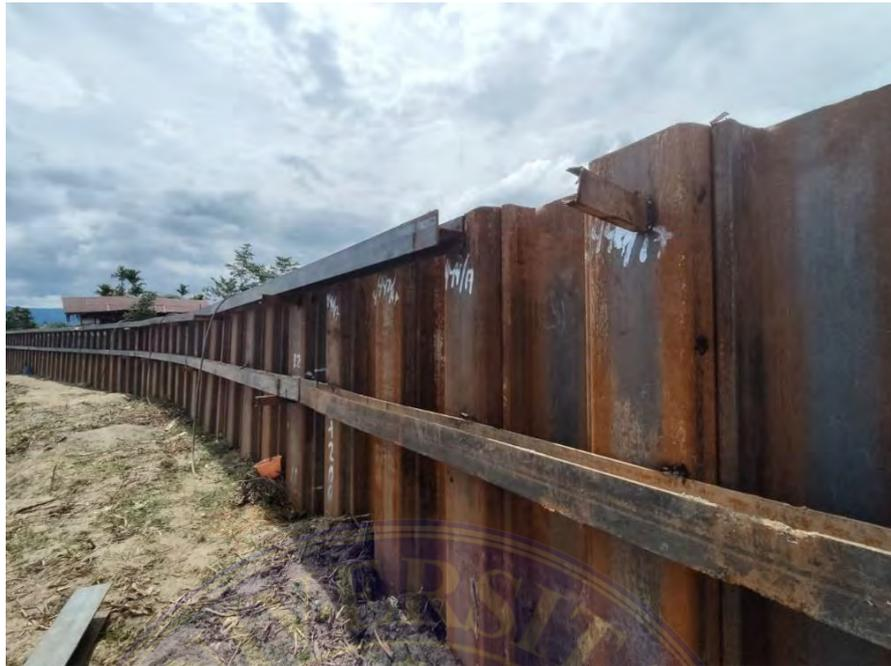
Gambar 4.11 *Pemasangan H Beam untuk Capping Beam*
