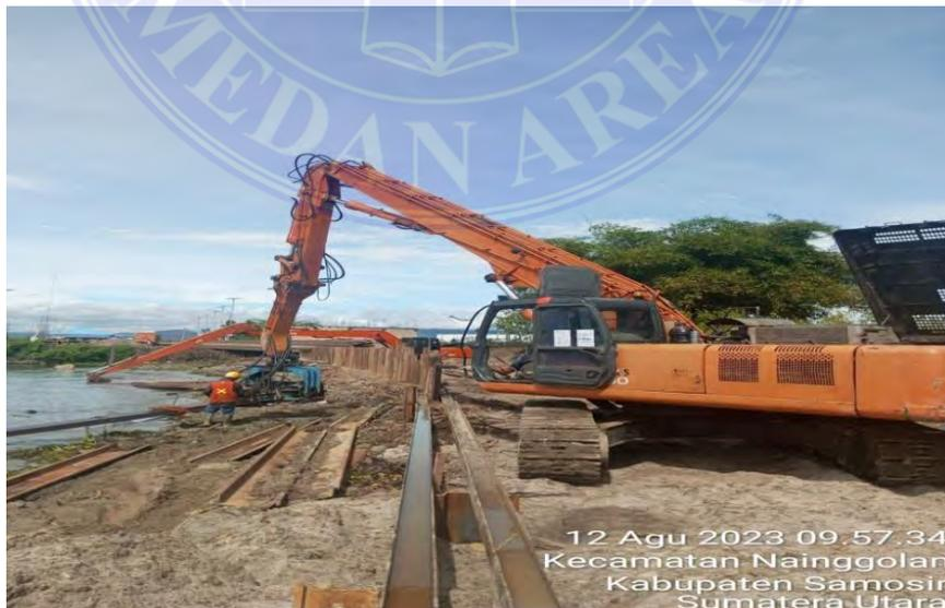
Gambar 4.3 Pemasangan *Guide Beam*
