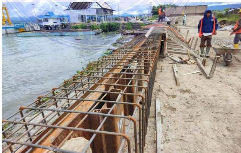
Gambar 4.10 Pemasangan tulangan capping beam
