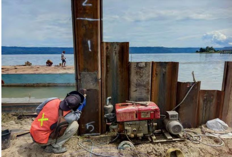
Gambar 3.10 Alat Las pada saat digunakan
