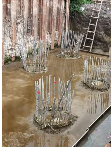
Gambar 4.3.4 Lantai Kerja Sumber : Data Lapangan
