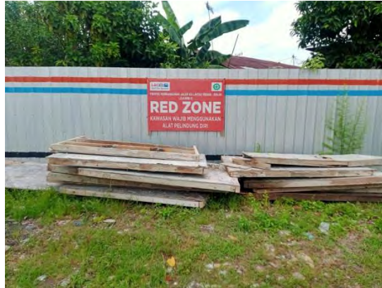
Gambar 3.1.8 Bekisting Sumber : Data Lapangan
