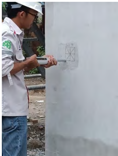
Gambar 4.3.7 Hammer Test Sumber : Data Lapangan
