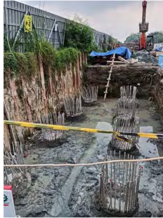
Gambar 4.3.3 Pembobokan Sumber : Data Lapangan
