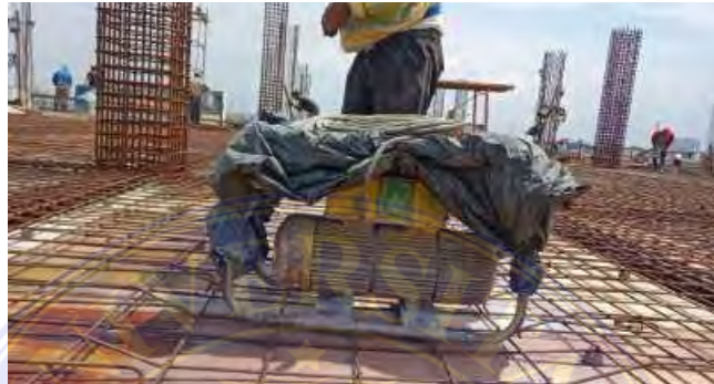
Gambar 3.1.4 Vibrator Sumber : Data Lapangan
