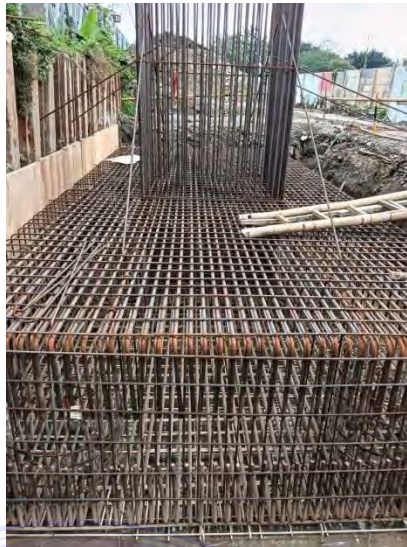
Gambar 4.3.5 Penulangan Pile cap Sumber : Data Lapangan
