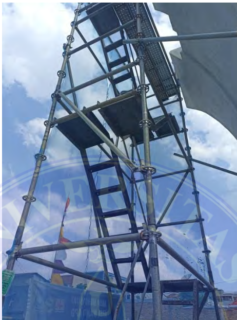
Gambar 3.1.18 Scaffolding Sumber : Data Lapangan
