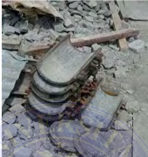
Gambar 3.1.24 Bekisting Silinder Sampel Sumber : Data Lapangan
