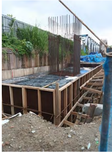
Gambar 4.3.6 Pemasangan Bekisting Sumber : Data Lapangan
