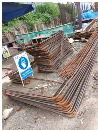
Gambar 3.2.2 Besi Tulangan Sumber : Data Lapangan
