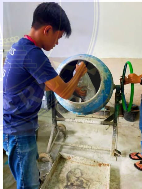
Campuran adukan beton Sumber: Dokumentasi lapangan, 2022
