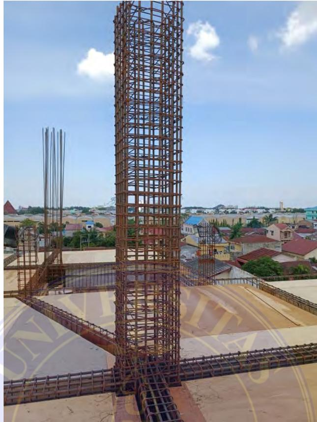
Gambar 4.3 Kolom Pada Lantai 3
