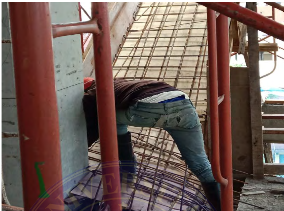
Gambar 3 Pemasangan penulangan Tangga
