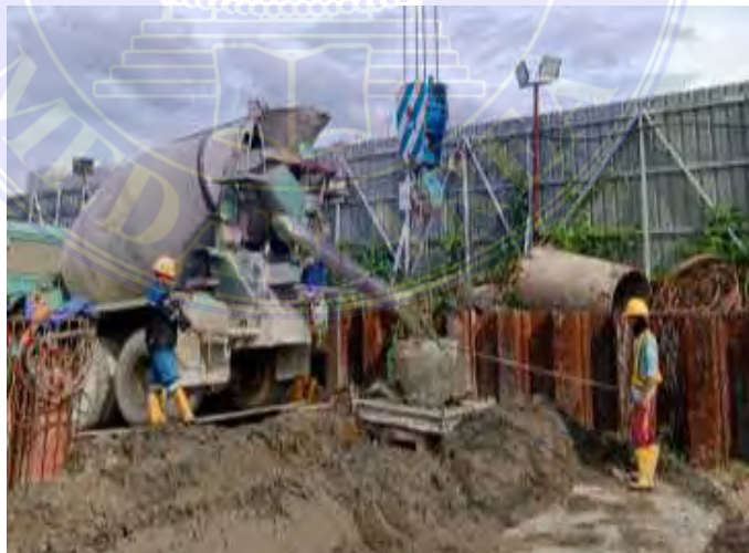
Gambar 3.1.9 Truck Mixer Beton Sumber : Data Lapangan
