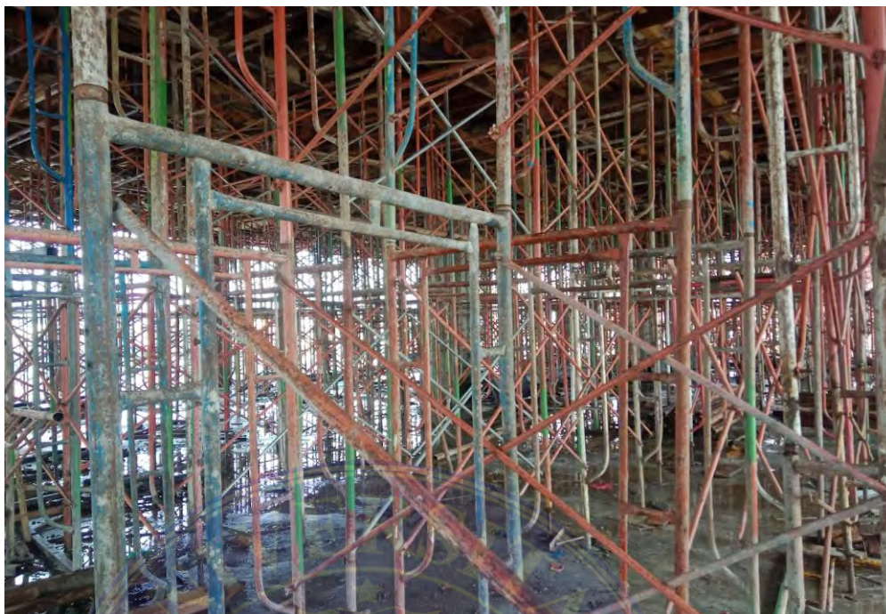
Gambar 1 Pemasangan Scaffolding
