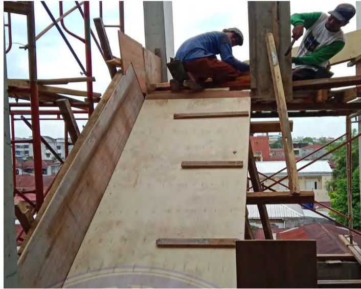
Gambar 3.1.8 Bekisting Sumber : Data Lapangan
