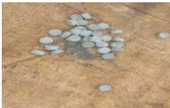
Gambar 3.2.12 Beton Decking Sumber : Data Lapangan
