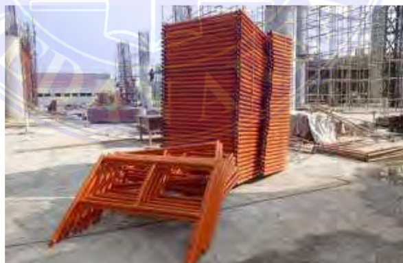
Gambar 3.1.19 Scaffolding Sumber : Data Lapangan
