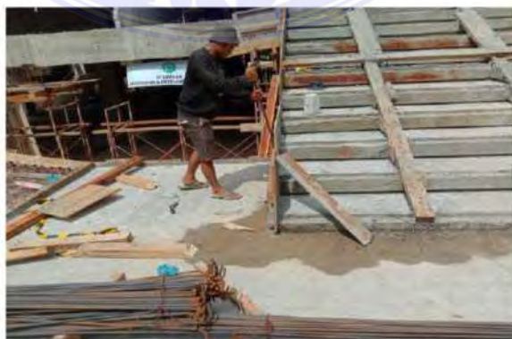
Gambar 4.3.6 Pembongkaran Bekisting Tangga Sumber : Data Lapangan
