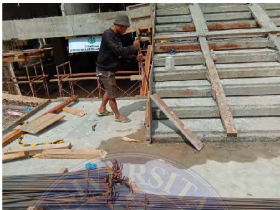
Gambar 5 Pembongkaran Bekisting Tangga
