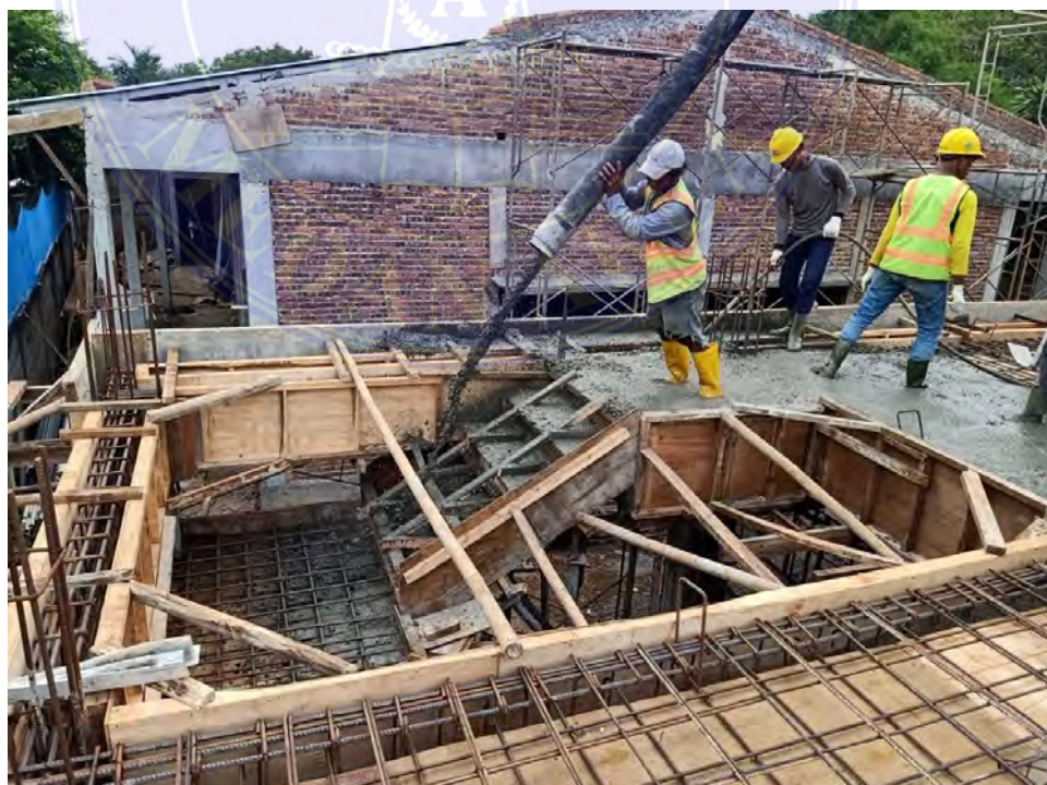
Gambar 4 Pengecoran tangga
