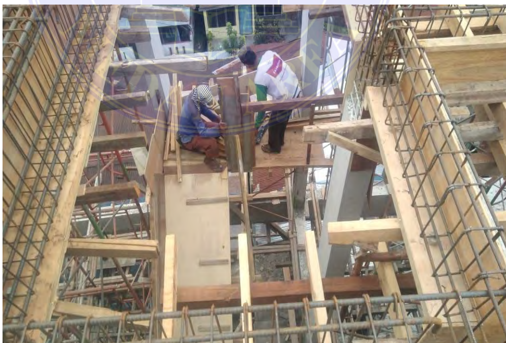
Gambar 2 Pemasangan bekisting Tangga
