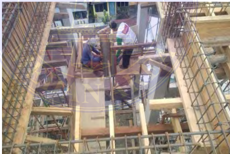
4.3.3 Pemasangan Bekisting Tangga Sumber : Data Lapangan
