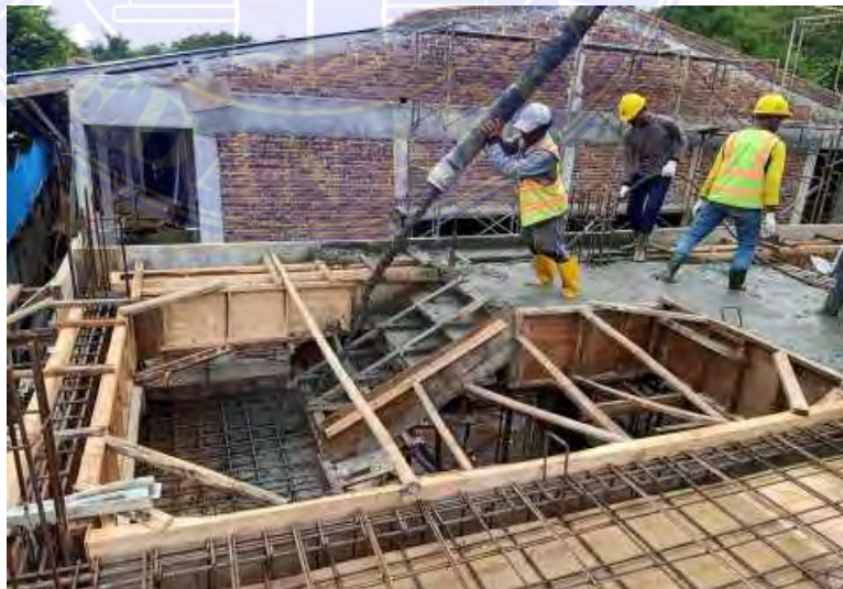
Gambar 4.3.5 Pengecoran Tangga Sumber : Data Lapangan
