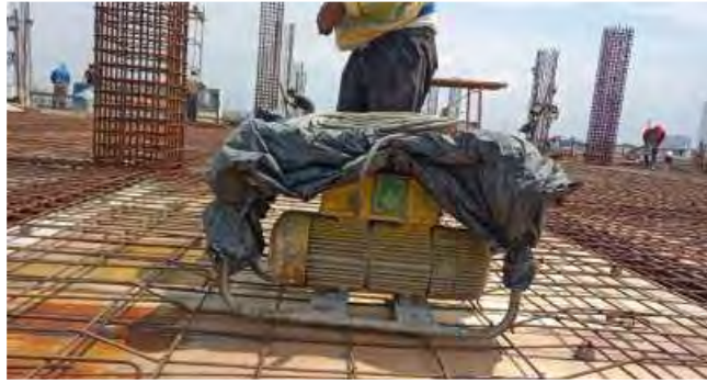
Gambar 3.1.4 Vibrator Sumber : Data Lapangan
