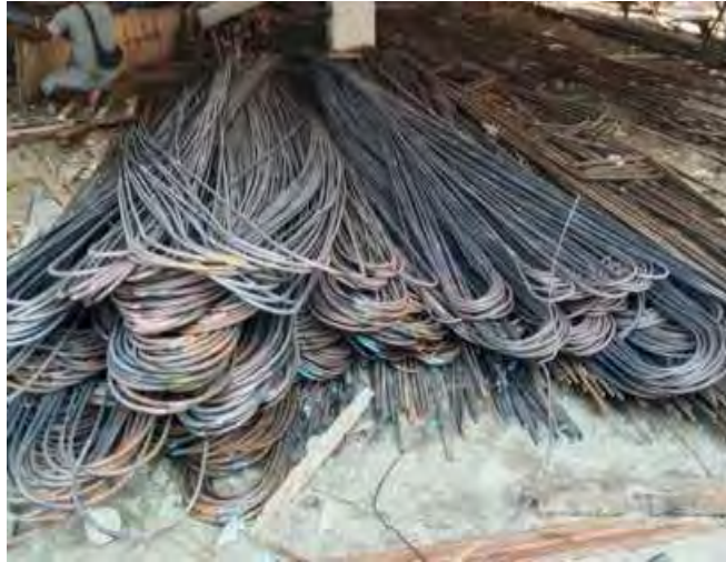
Gambar 3.2.2 Besi Tulangan Sumber : Data Lapangan
