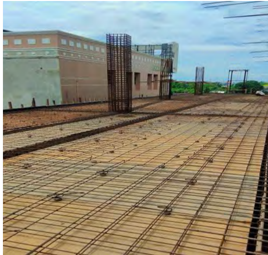
Gambar 3 Pemasangan Tulangan Sumber : Data Lapangan
