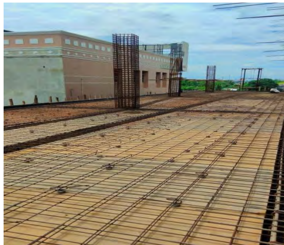
Gambar 4.33 Pemasangan Tulangan
