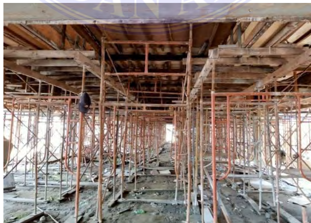
Gambar 4.31 Pemasangan Scaffolding . Sumber : Data lapangan
