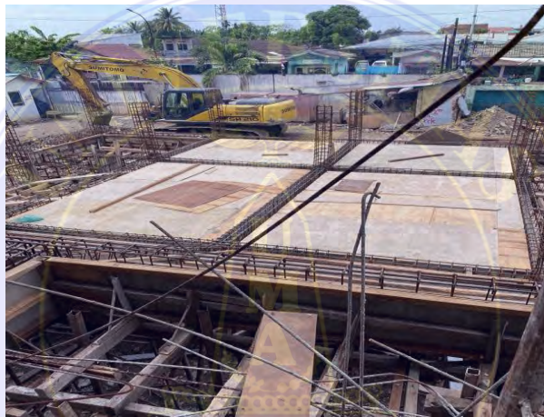
Gambar 2 Pemasangan Bekisting Sumber : Data Lapangan
