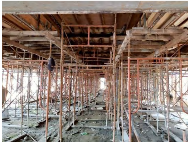
Gambar 1 Pemasangan Scaffolding . Sumber : Data lapangan
