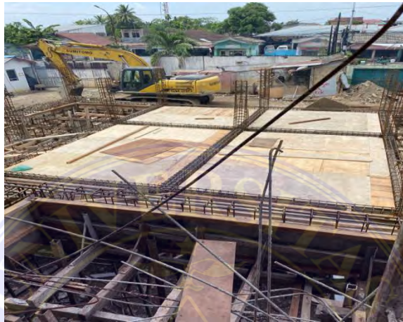
Gambar 4.32 Pemasangan Bekisting Sumber : Data Lapangan
