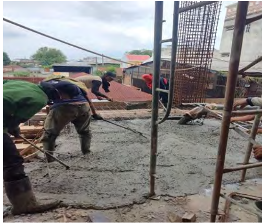
Gambar 4 Pengecoran Plat Lantai Sumber : Data lapangan
