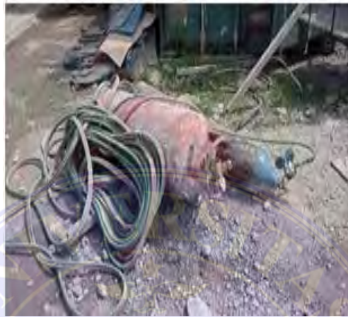
Gambar 3.28 Cutting Torch Sumber : Data Lapangan
