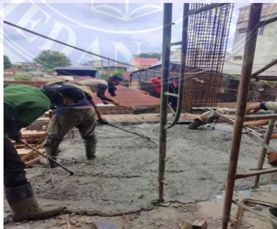
Gambar 4.34 Pengecoran Plat Lantai
