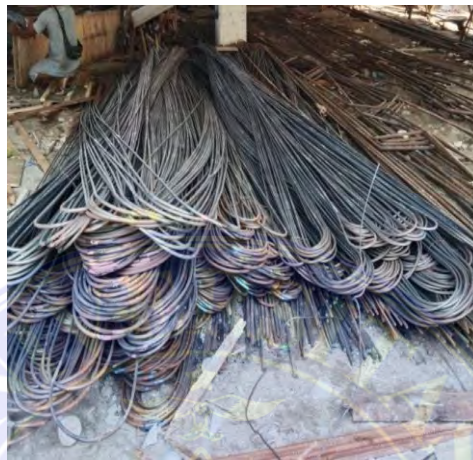
Gambar 3.33 Besi Tulangan Sumber : Data Lapangan
