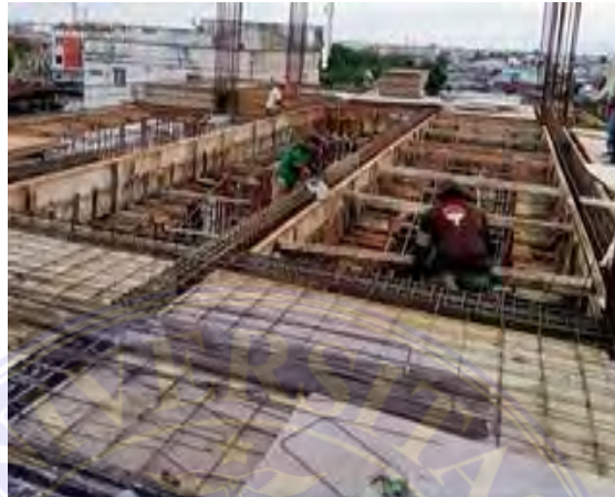
Gambar 3.8 Bekisting Sumber : Data Lapangan
