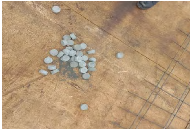
Gambar 3.42 Beton Decking Sumber : Data Lapangan
