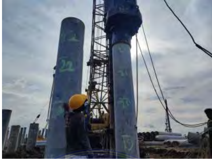
Gambar 4. 2 Pondasi Tiang pancang
