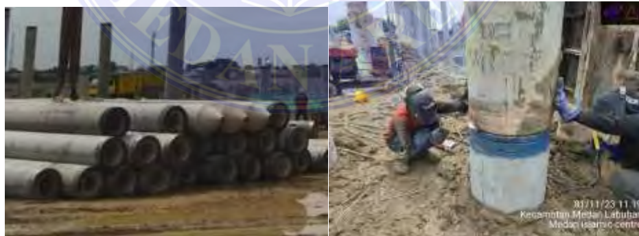
Gambar 4. 4 Proses Penyambungan Sumber : Data Lapangan
