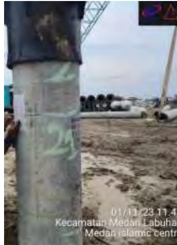
Gambar 4. 6 Tanda Tiang pancang Sumber : Data Lapangan
