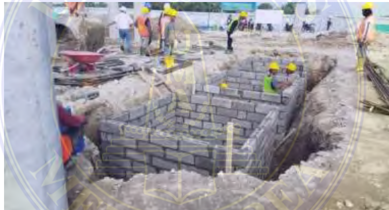
Gambar 3. 7 Bekisting Bata Sumber : Data Lapangan
