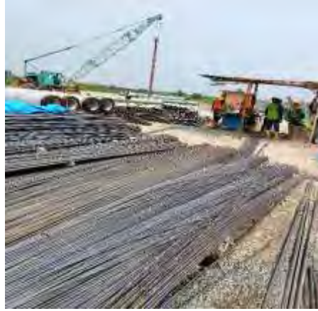
Gambar 3. 25 Besi Tulangan Sumber : Data Lapangan
