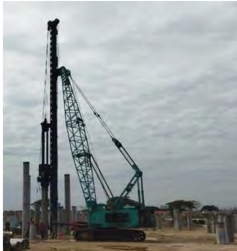
Gambar 4. 3 Diesel Hammer Sumber : Data Lapangan
