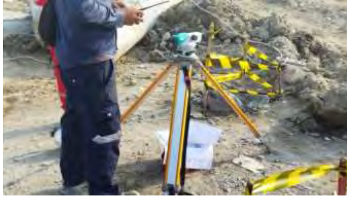
Gambar 3. 4 Waterpass Sumber : Data Lapangan
