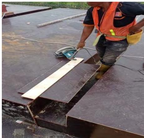
Gambar 4. 1 Pemasangan *Bekisting*
