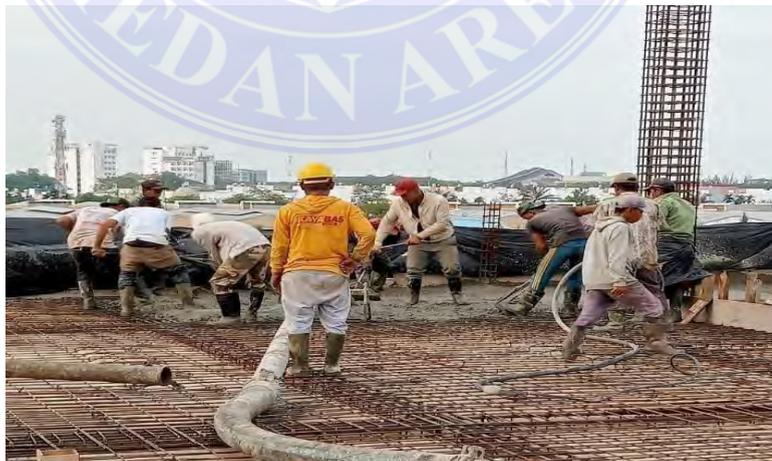
Gambar 4.34 Pengecoran Plat Lantai
