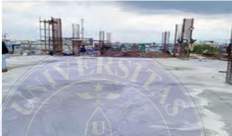
Gambar 4.35 Pekerjaan Pembongkaran Bekisting Plat Lantai
