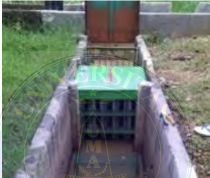
Gambar 13: Filter Air Embung Untuk Irigasi
