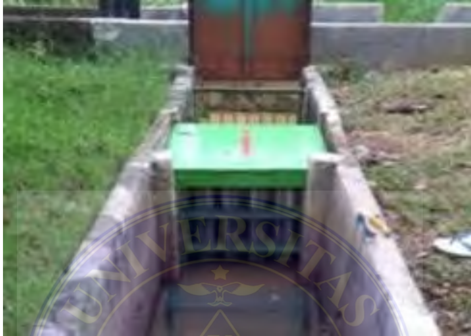
Lampiran 7. Filter Air Untuk Saluran Irigasi
