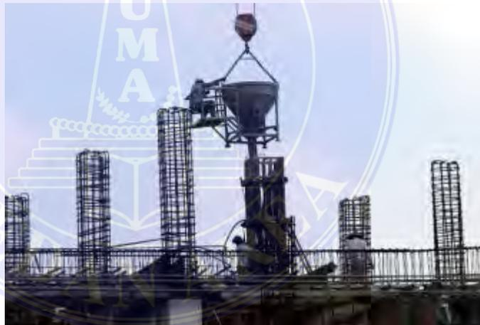
**Gambar 4.9 Proses Pengecoran Kolom 1**
