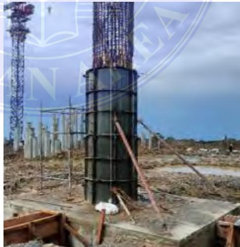
**Gambar 4.6 Pemasangan Bekisting Kolom 1**
