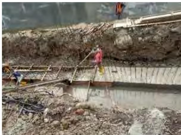
Gambar 4.8 *Pondasi* setelah di cor
