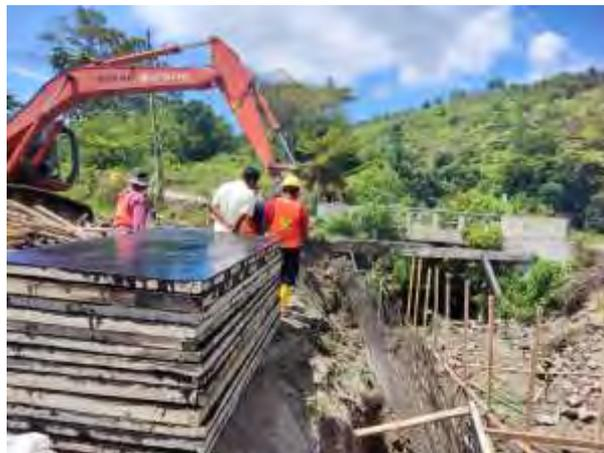
Gambar 3.7 Kayu Multipleks digunakan untuk Membuat Bekisting
