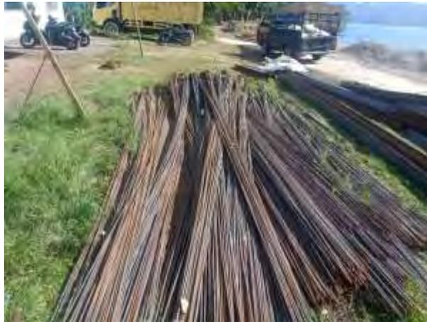
Gambar 3.8 Besi atau Tulangan polos yang siap untuk digunakan
