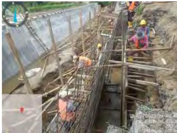
Gambar 4.5. Proses Pemasngan Bekisting pondasi/ sloff
