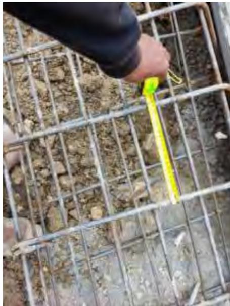
Gambar 4.1 Proses Perakitan Besi bekisting/ *sloff*
