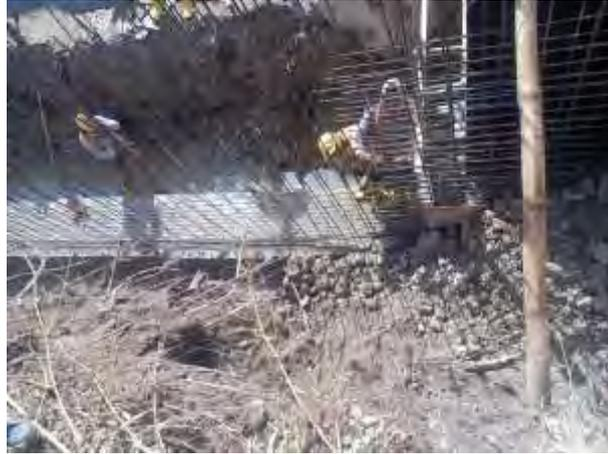
Gambar 4.6. Proses pengikatan pondasi ke kolom bekisting keseluruhan
