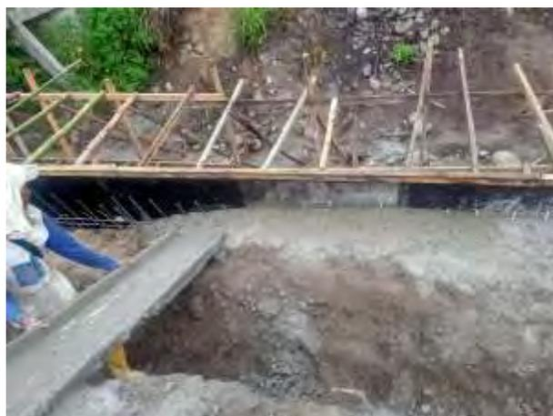
Gambar 3.5 Beton *Ready Mix* dari Molen Siap Digunakan
